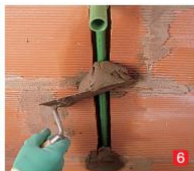
6) fixace vodovodních potrubí
