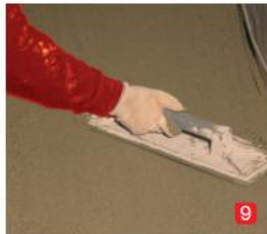
9) Ruční dokončení hladítkem.
