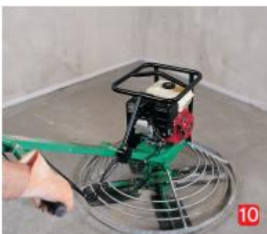
10) Mechanické dokončení vrtulovou leštičkou.
