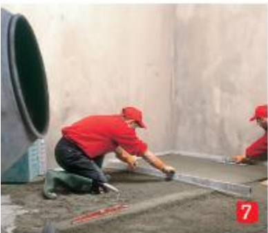
7) Nanášení pomocí podélných pruhů.
