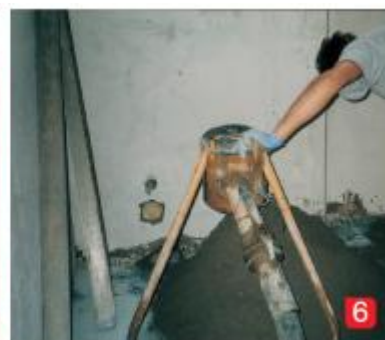
6) Doprava směsi pomocí čerpadla na betony.
