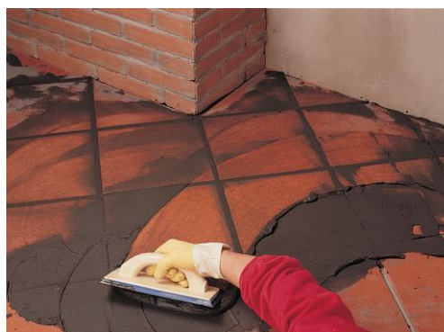
2) Stěrkou odstraňte přebytky hmoty
