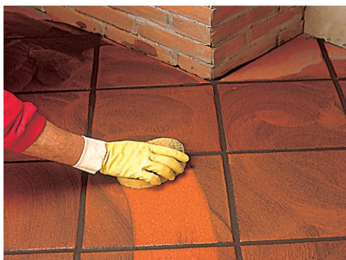
4) Dokončete čištění jemnou vlhkou houbou.
