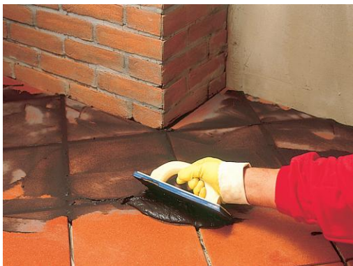
1) Aplikujte hmotu gumovou stěrkou pečlivě do všech spár
