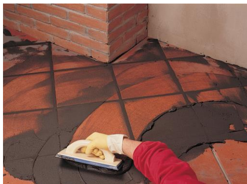
2) Stěrkou odstraňte přebytky hmoty
