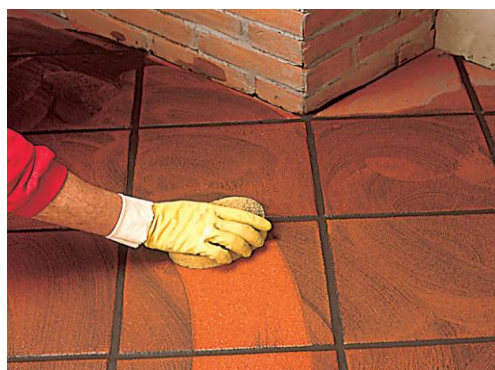
4) Dokončete čištění jemnou vlhkou houbou.
