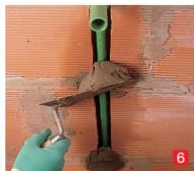
6) fixace vodovodních potrubí
