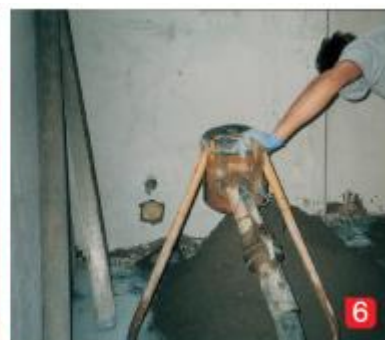
6) Doprava směsi pomocí čerpadla na betony.
