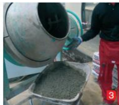
3) Příprava hmoty v míchačce.
