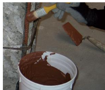
3) Naneste na armovací železa výrobek ADEFER
