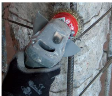
2) Očistěte armovací železa
