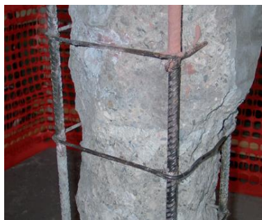
1) Odstraňte nesoudržné části
