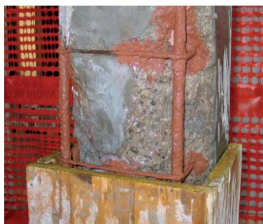
4) Umístěte formy a navlhčete podklad vodou
