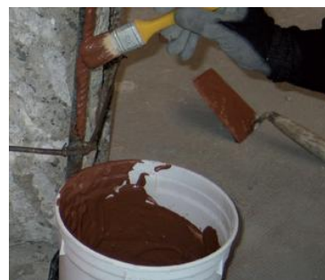
3) Naneste na armovací železa výrobek ADEFER
