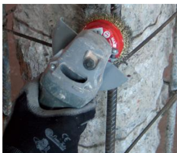
2) Očistěte armovací železa
